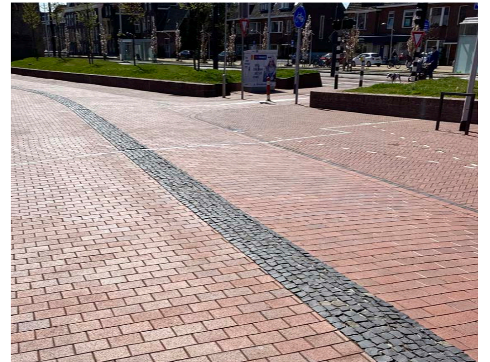
Figuur 3.9 Referentie natuurstenen middenstrook als snelheidsremmende maatregel
