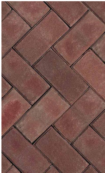
Figuur 3.5 Rijwegen: klinkers, keiformaat, Puccini roodbruin, keperverband
