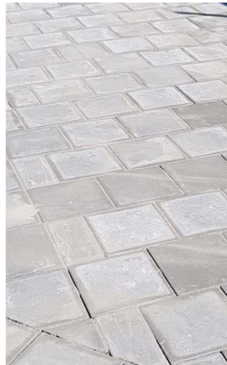
Figuur 3.7 Trottoirs: tegels 30x30x4,5 cm, standaard lichtgrijs, halfsteensverband
