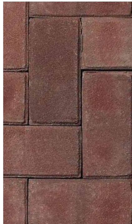
Figuur 3.6 Parkeervakken: klinkers, keiformaat, Puccini roodbruin, elleboogverband
