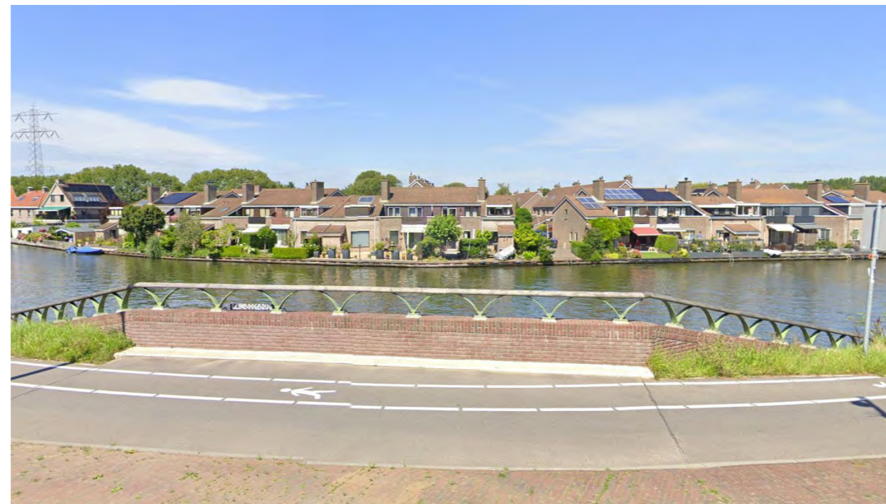
Figuur 3.26 De Geinboogbrug bij de kruising van het Zandpad en de N236
