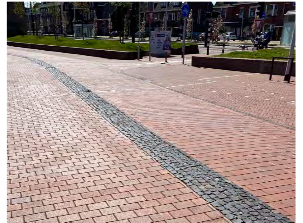
Figuur 3.9 Referentie natuurstenen strip als snelheidsremmende maatregel
