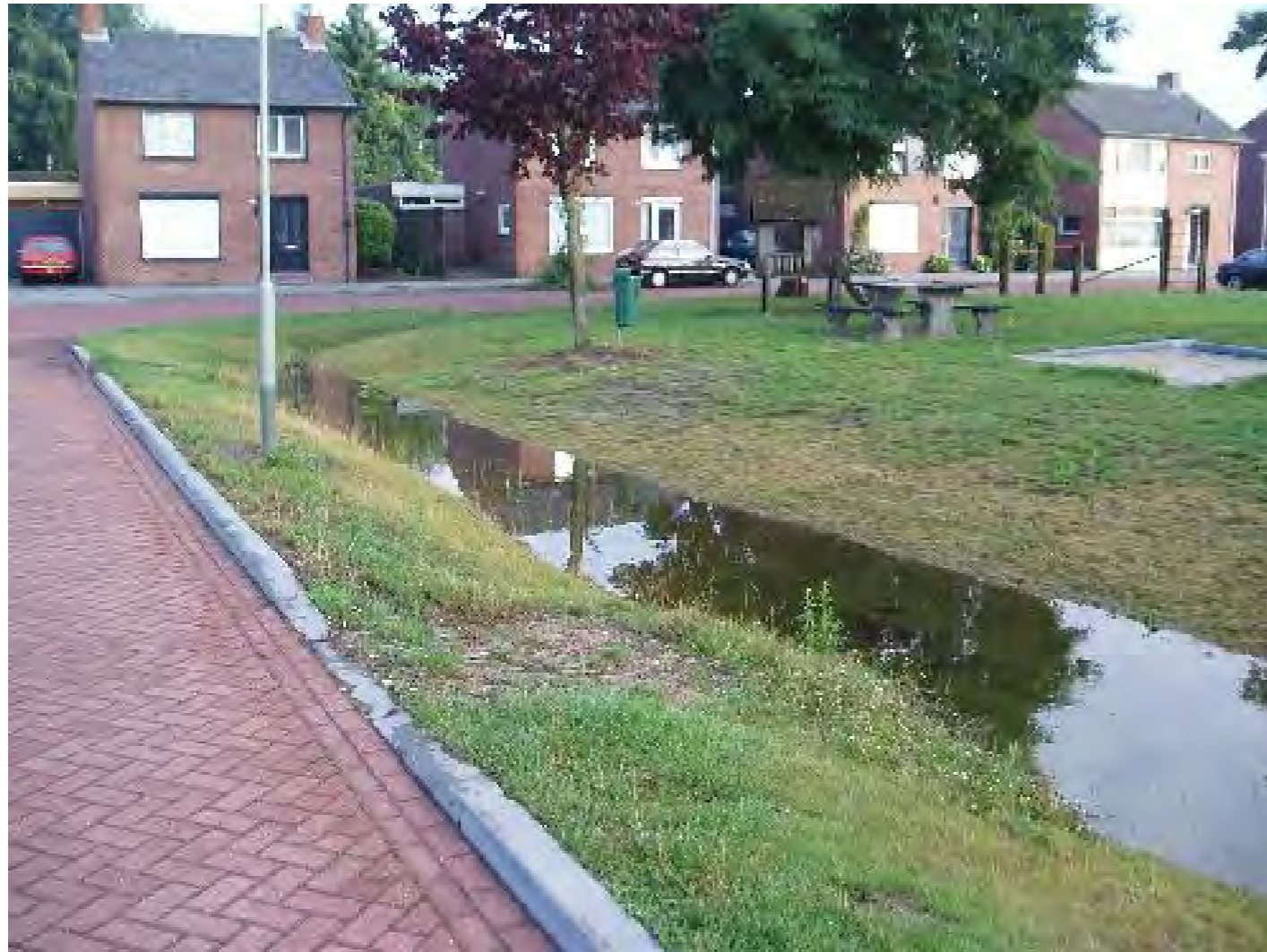
Figuur 1.2 Afvoer van regenwater op het oppervlaktewater waar de trottoirband wordt verlaagd.
