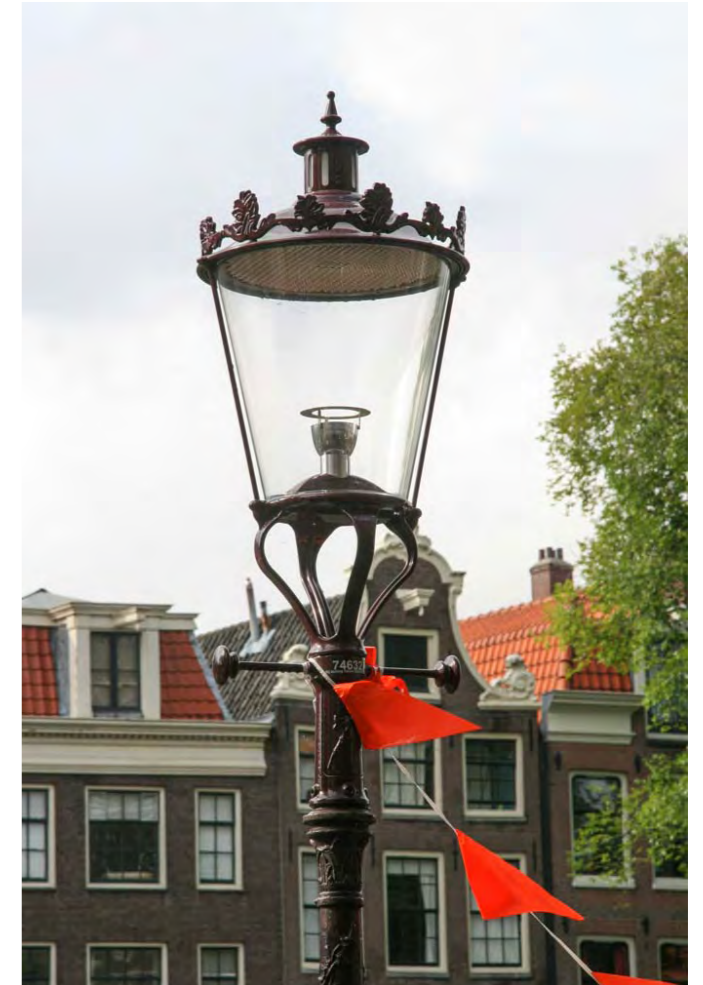
Figuur 3.16 Klassieke lichtmast (1883) met Ritter armatuur
