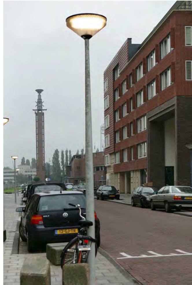
Figuur 3.14 Standaard lichtmast
