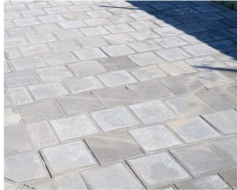
Fig 3.7 Trottoirs: tegels 30x30x4,5, standaard lichtgrijs, halfsteensverband
