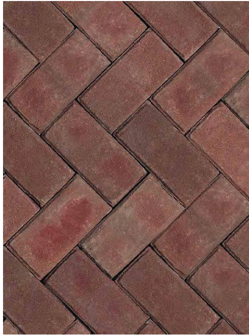
Fig 3.5 Rijwegen: klinkers, keiformaat, Puccini roodbruin, keperverband
