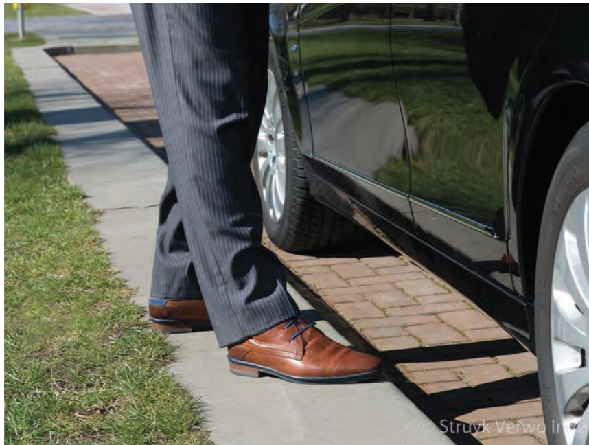
Fig. 3.9 Uitstapband bij gazon en beplanting: trottoirband 38/40x25
