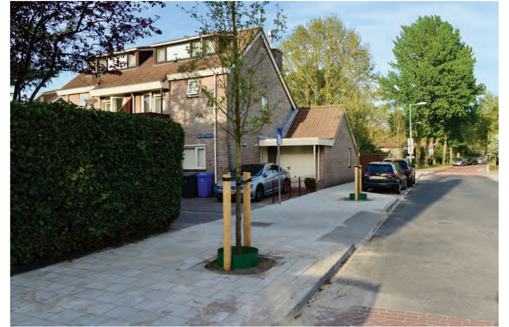
Fig. 3.8 Boomspiegels: boomkransselement 45x45x10 met boomkransverlengstuk 30x10x10 (totale buitenafmeting 120x120)
